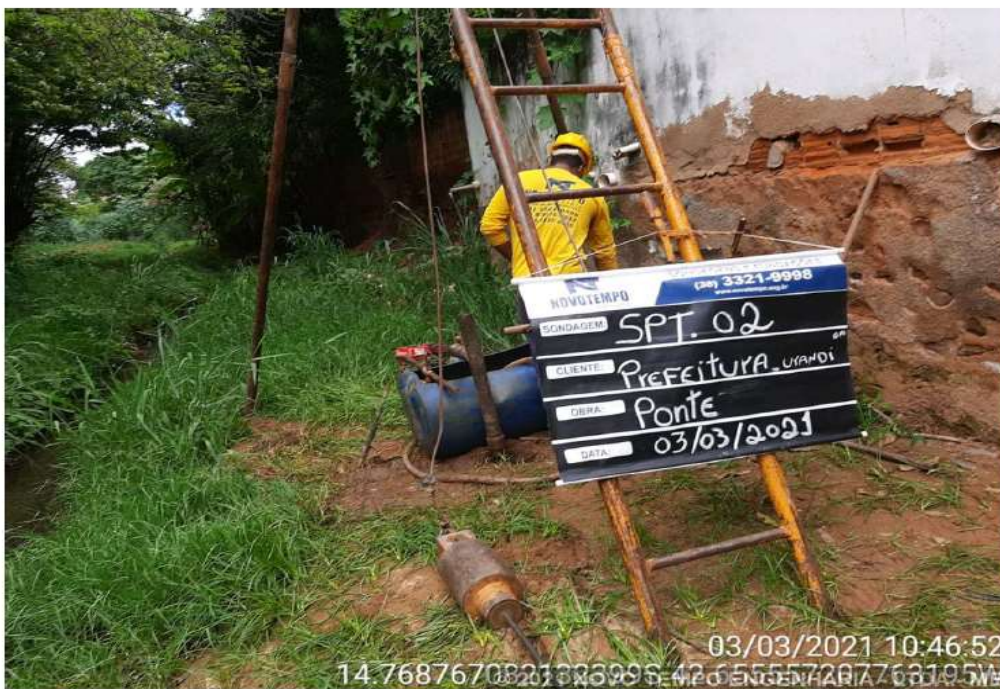
EXECUÇÃO SONDAGEM À PERCUSSÃO SP 02 - URANDI/BA
