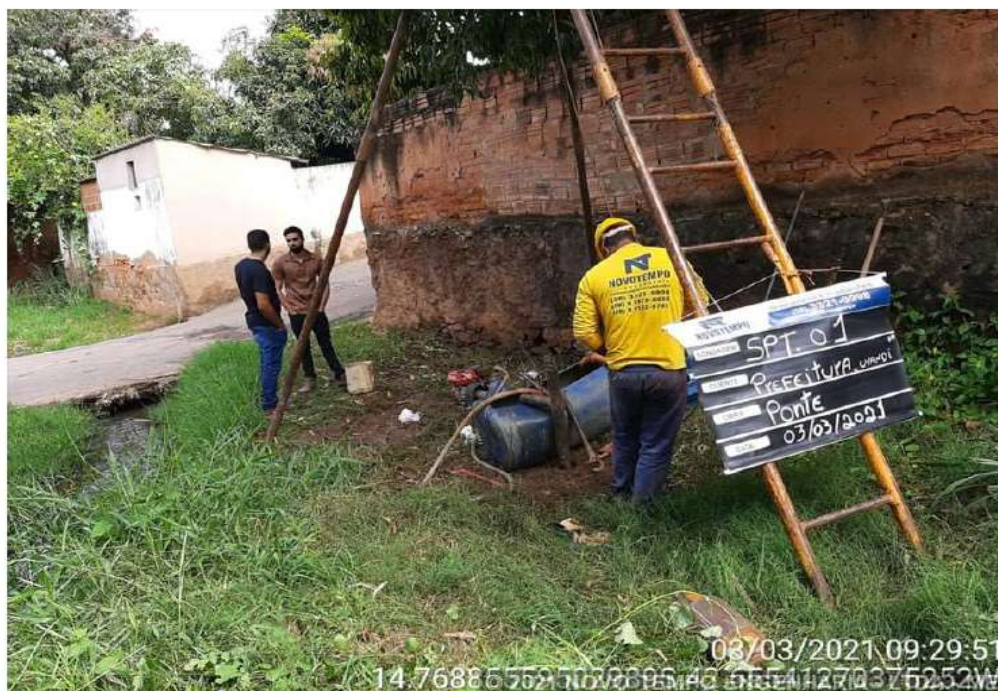
EXECUÇÃO SONDAGEM À PERCUSSÃO SP 01 - URANDI/BA
