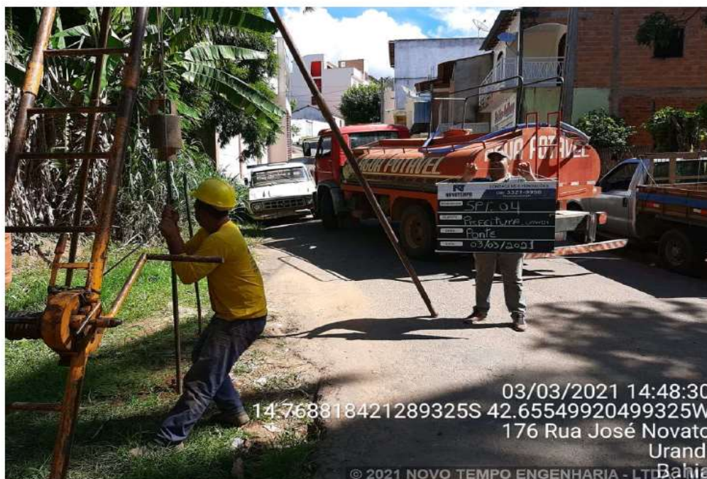
EXECUÇÃO SONDAAGEM À PERCUSSÃO SP 04 - URANDI/BA
