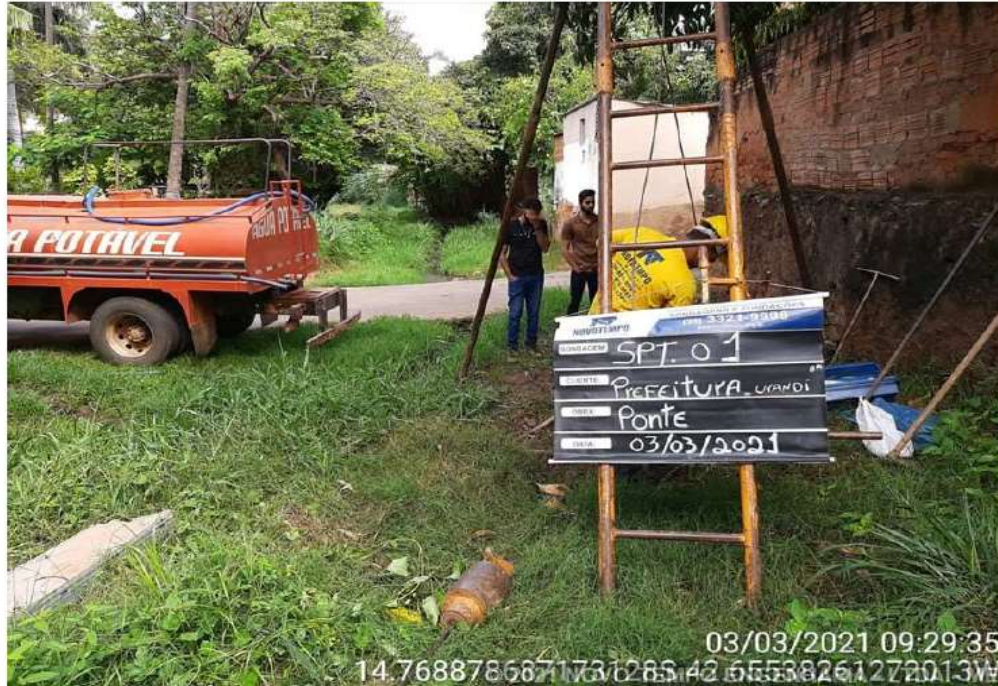
EXECUÇÃO SONDAGEM À PERCUSSÃO SP 01 - URANDI/BA
