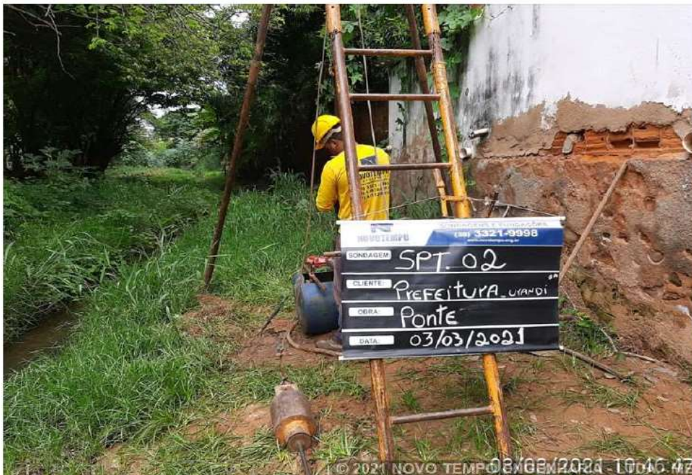
EXECUÇÃO SONDAGEM À PERCUSSÃO SP 02 - URANDI/BA
