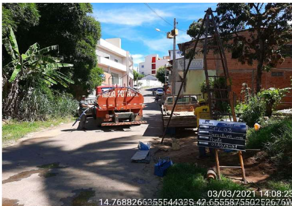
EXECUÇÃO SONDAÇÃO À PERCUSSÃO SP 03 - URANDI/BA
