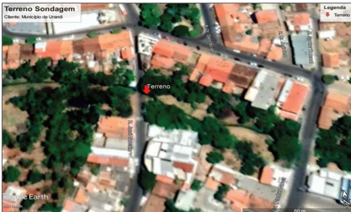
Imagem 1 – Terreno – Fonte: Google Earth
